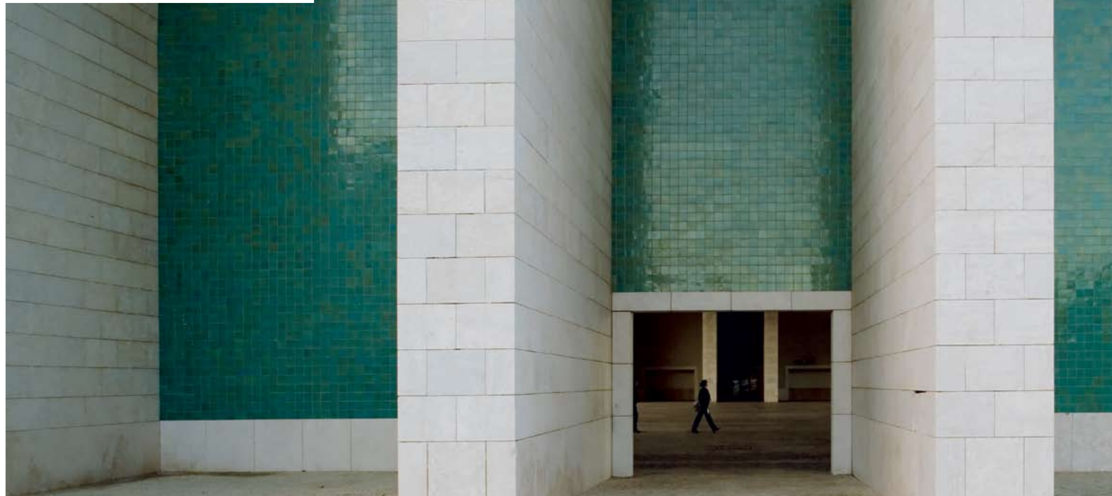
ARQ. SIZA VIEIRA. PAVILHÃO DE PORTUGAL, EXPO (LISBOA)
