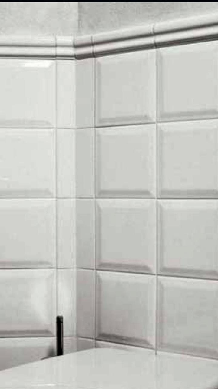
In presenza di un angolo interno maggiore o minore di  $90^\circ$ , utilizzare la piastrella piana per i tagli e sagomare la cornice e il battiscopa con l'angolatura necessaria. Non utilizzare lo sguscio interno e l'angolo interno di cornice e battiscopa.
