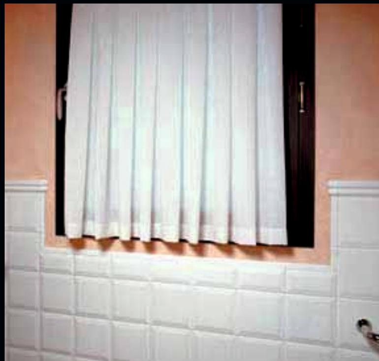
In prossimità della cornice di porta e finestra, fermarsi con la posa all'ultima piastrella intera, utilizzando il Bullnose per rifinire la costa non smaltata della piastrella stessa e il terminale dx/sx per cornice e battiscopa.
