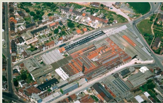
Notre usine à Lomme. Наша фабрика в Ломме.
