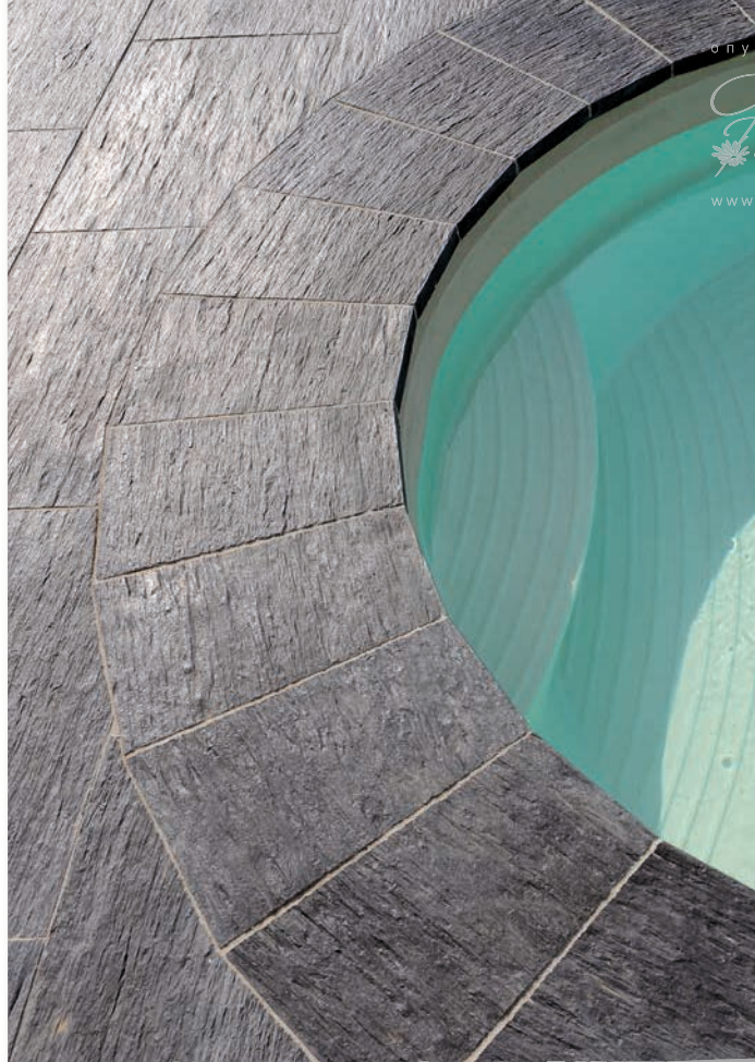
Plage de piscine réalisée avec la dalle Ardoisière et la margelle droite Ardoisière
